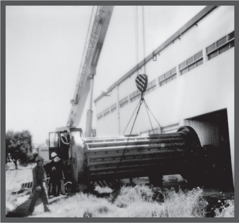
Proceso de construcción de las Plantas en Tlaxcal.
